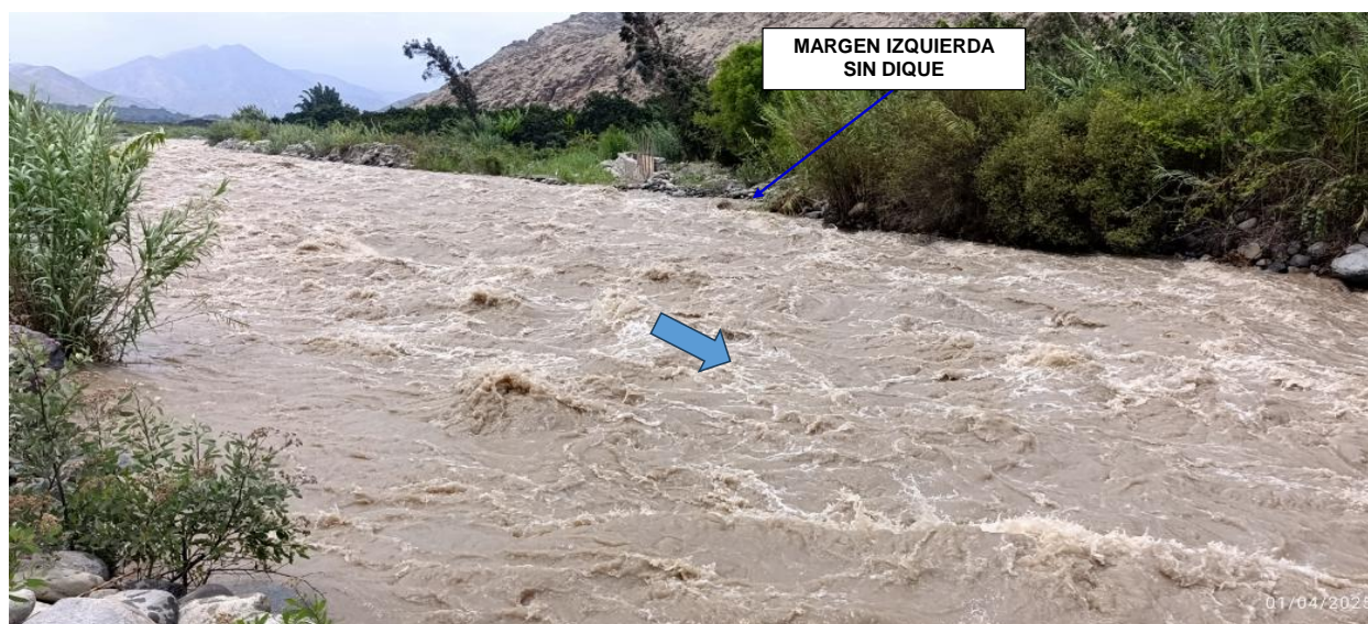
FIGURA N°02: TRAMO CRÍTICO EN EL RIO CHANCAY - HUARAL, SECTOR QUIUQUIN CON DIQUES EROSIONADOS EN AMBOS LADOS DEL CAUCE, A SU VEZ EL CAUCE SE ENCUENTRA REDUCIDO.
