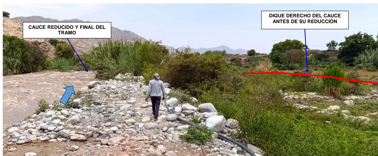
FIGURA N°04: RIO CHANCAY - HUARAL, SECTOR QUIUQUIN - CUYO CON EL CAUCE REDUCIDO Y EN LA MARGEN DERECHA SE APRECIA PARTE DEL DIQUE ANTERIOR A LA REDUCCIÓN.
